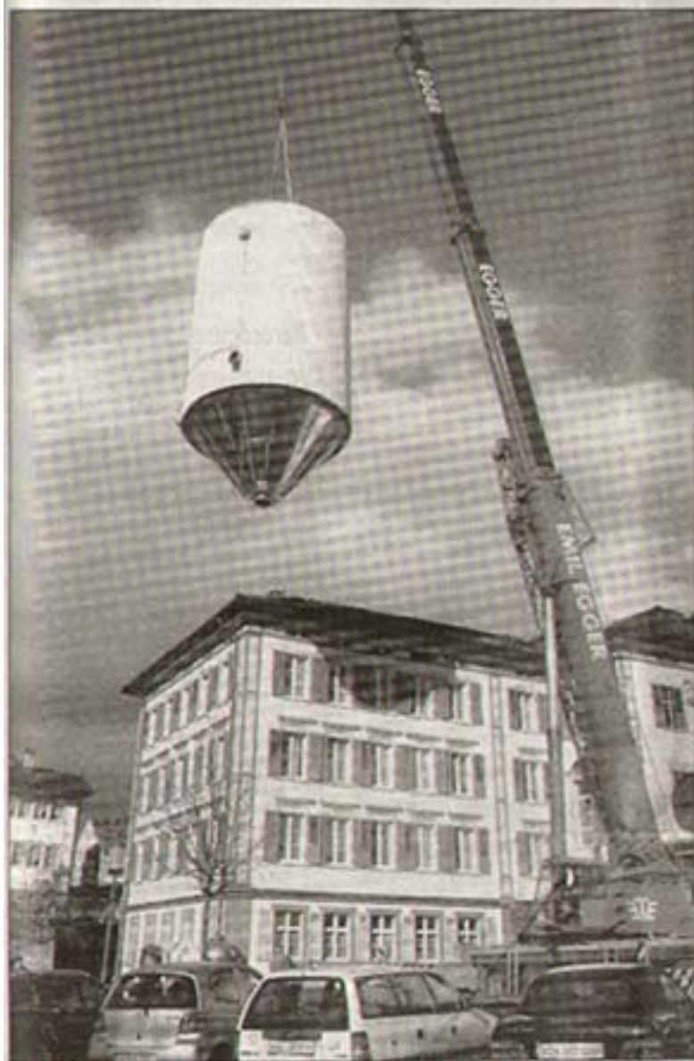
Kraftakt: Einer der beiden Tanks wird vom Hebekran über das Hauptgebäude der Brauerei Locher AG gehievt. (Bilder: Josef Fritsche)
